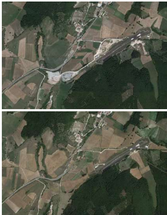
Figura 24. Nell'immagine sopra (2016) sono visibili le aree di cantiere per i lavori sulla strada statale 77 della Val di Chienti, a Foligno. Sotto la stessa area ripristinata nel 2018
