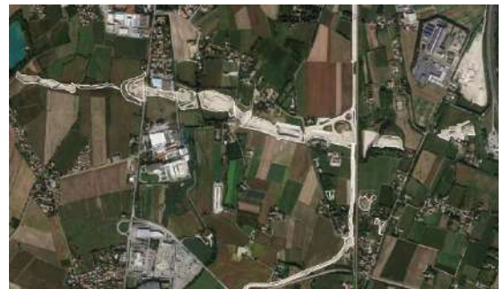
Figura 77. Cantieri stradali per la Pedemontana Veneta tra i comuni di Spresiano e Villorba (TV)
