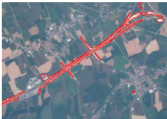
Figura 103. Lavori di realizzazione della 3ª corsia dell'autostrada A4
