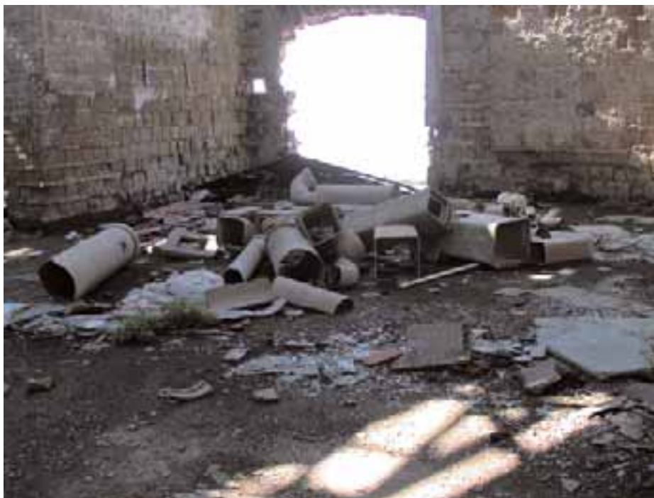
Figura 9.6 - Materiali contenenti amianto (MCA) presenti nei locali di un sito industriale abbandonato
