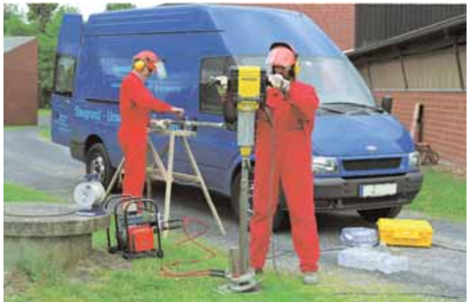
Figura 2.10 - Carotaggio mediante infissione a percussione di carotiere. Un allestimento come quello in figura consente di spostarsi facilmente da una postazione all'altra e di raggiungere postazioni in spazi molto ristretti o di difficile accessibilità (ad es. all'interno dei bacini di contenimento dei serbatoi o all'interno di edifici). Il carotiere utilizzato con questi sistemi può essere del tipo finestrato o con fustella
