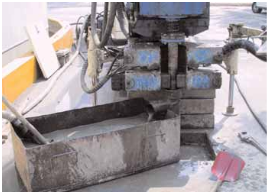
Figura 2.6 - Quando non è possibile operare a secco, la perforazione può essere agevolata mediante l'uso di acqua di qualità nota (meglio se potabile). Tutta l'acqua risultante dalle operazioni di perforazione e alesaggio del foro di sondaggio deve essere raccolta in apposite vasche, analizzata e, all'occorrenza, trattata adeguatamente prima dello scarico
