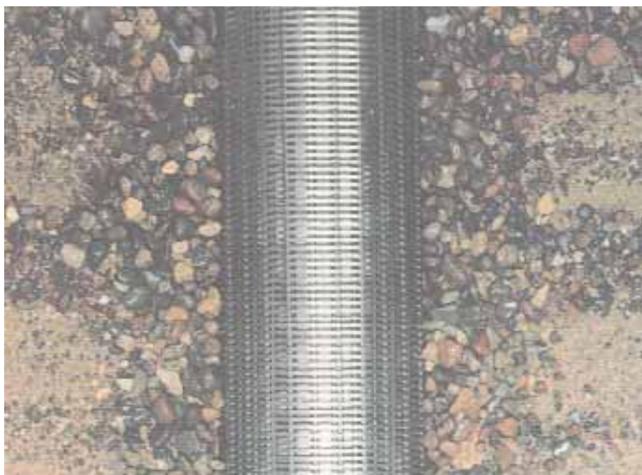
Figura 3.14 (da F.G. Driscoll, Groundwater and Wells , 1986) - Immagine di un filtro installato all'interno di un pozzo. Il materiale più grossolano a ridosso delle pareti filtranti è il cosiddetto dreno, il materiale più fine è quello che causa i problemi di ostruzione dei filtri
