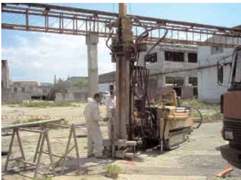
Figura 2.15 - Trivella montata su cingoli
