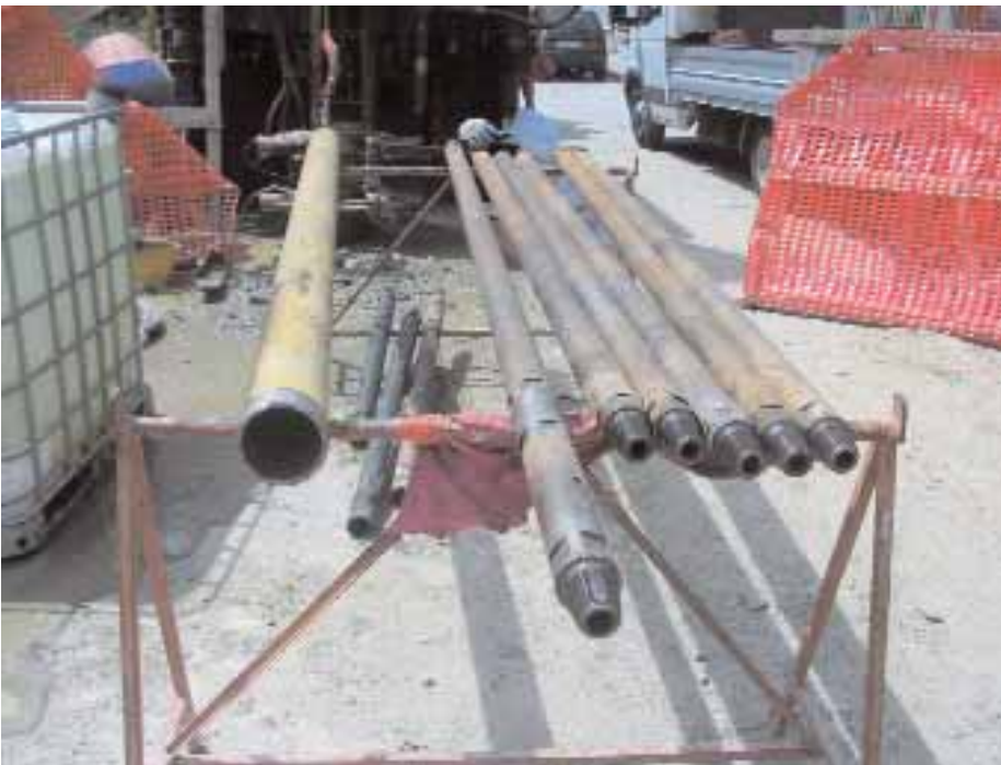
Figura 2.7 - Carotiere semplice (a sinistra) e batteria di aste cave di perforazione
