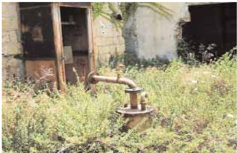
Figura 9.5 - Boccapozzo di un pozzo di approvvigionamento dismesso. Per effettuare la misura del livello statico o ispezioni televisive, in questo caso è necessario rimuovere la copertura in ferro ed eventualmente la pompa installata all'interno del pozzo stesso
