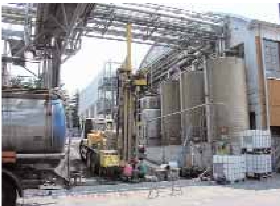
Figura 2.14 - Trivella su gomma al lavoro al di sotto di un "rack" con servizi aerei
