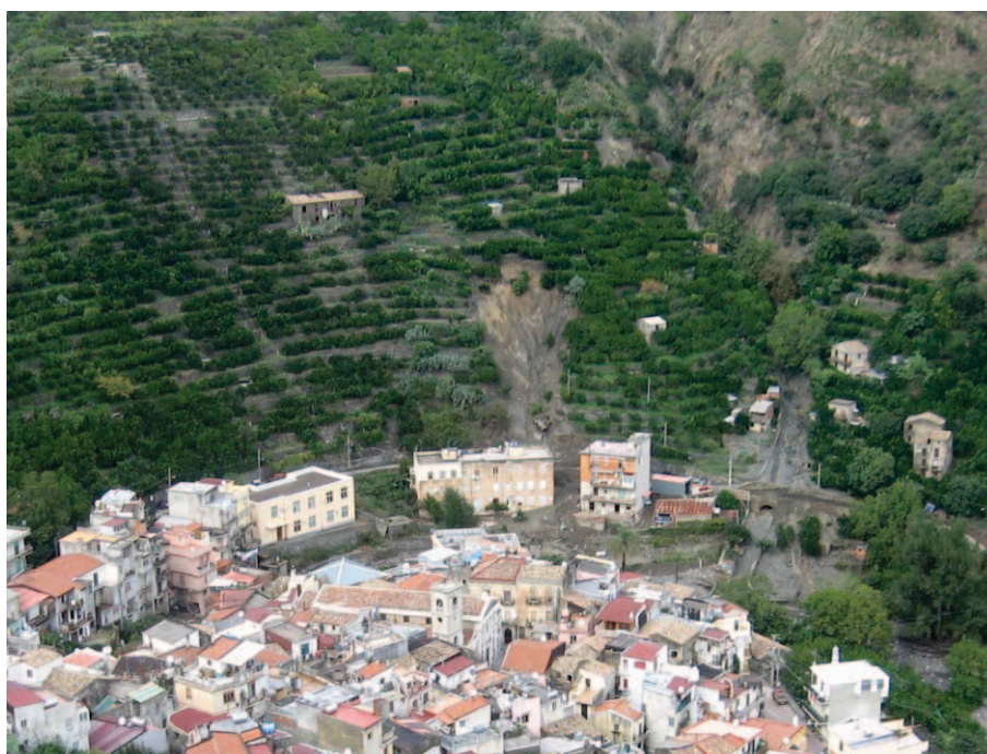
Figura 3.6 - Frana superficiale su terrazzamenti, Altolia (ME)
