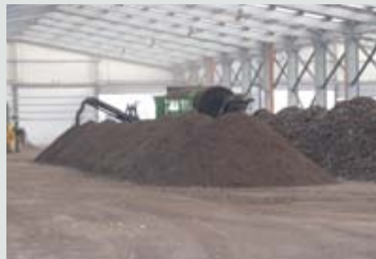
Foto 2 — Impianto di compostaggio
